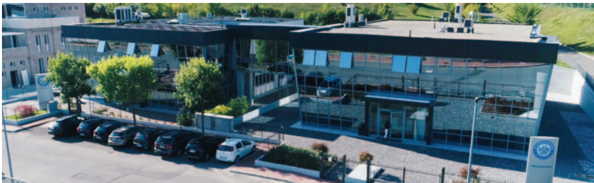
La sede di ECM a Valsamoggia.
